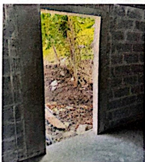
Foto 5: Instalación de puerta
