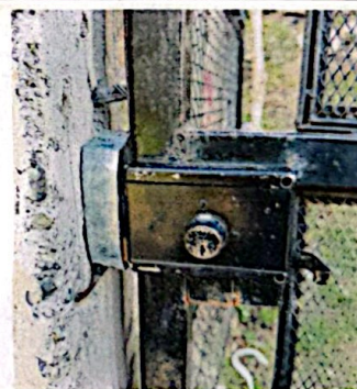
Foto 6: Mantenimiento a portón
