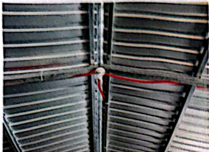
Foto 1: Mejoramiento de sistema eléctrico
