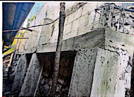
Foto 5: Mantenimiento de muro de contención
