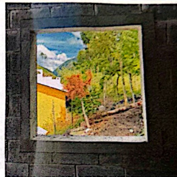
Foto 4: Instalación de ventanas
