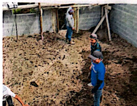
Foto 4: Mejoramiento de piso
