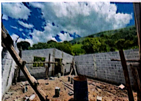
Foto 1: Mejoramiento aula tipo pórtico
