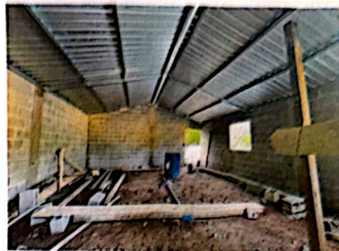
Foto 2: Instalación de estructura de techo
