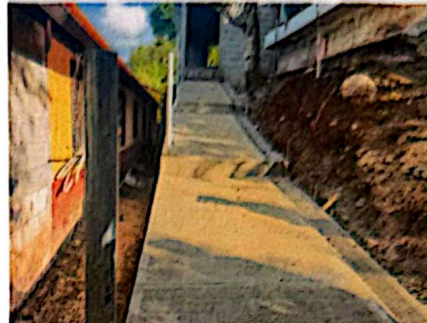
Foto 2: Instalación de baranda
