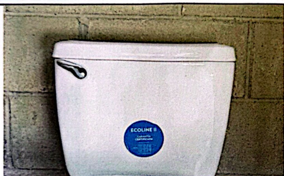
Foto 3: Mejoramiento de servicio sanitario
